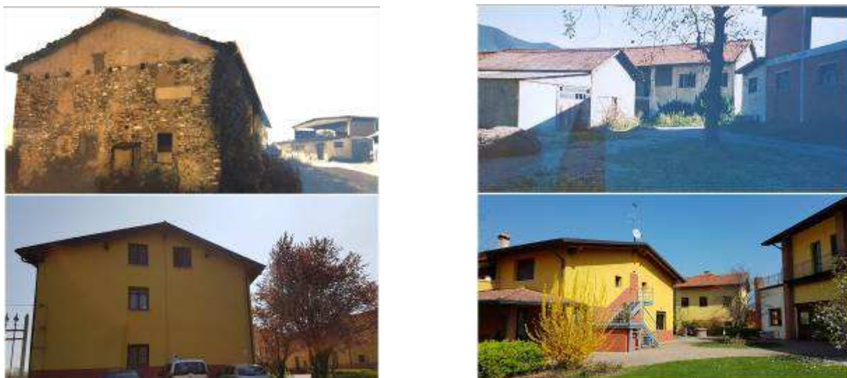
Fotografia 1: La Cascina Clarabella prima e dopo gli interventi di ristrutturazione
